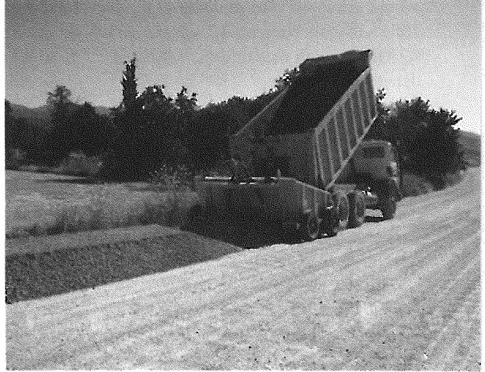
Köydes 2008 çalışmalarından (Hasköy yolu)
